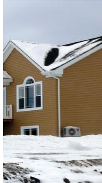
Construction de nouvelles habitations
